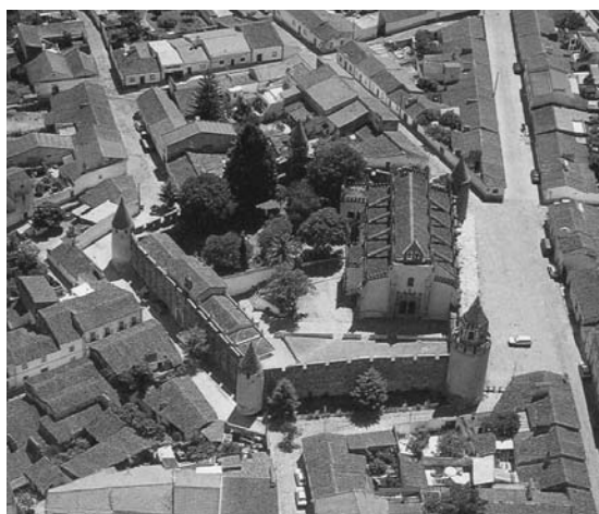
Fig. 1 Vista geral do conjunto monumental do Castelo de Viana do Alentejo.
