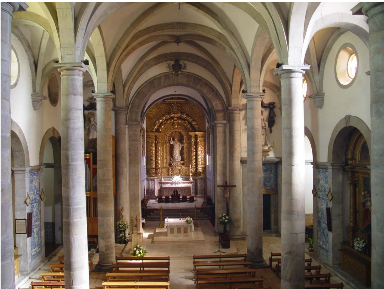
Figura 4. Vista das naves e capela-mor, antes das obras.
