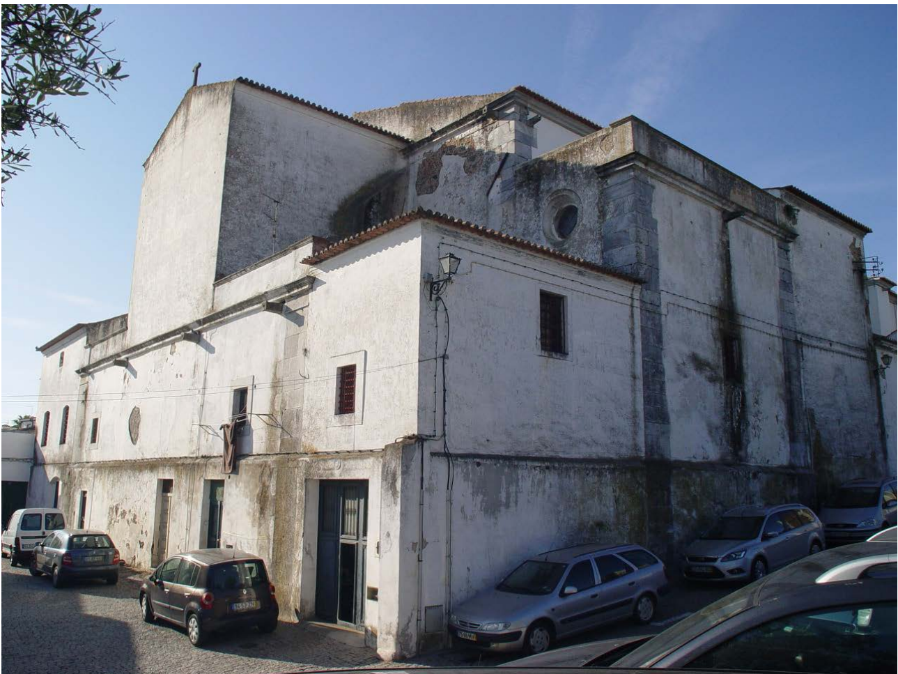
Figura 2. Alçado poente e alçado norte, com os corpos adossados, antes das obras.
