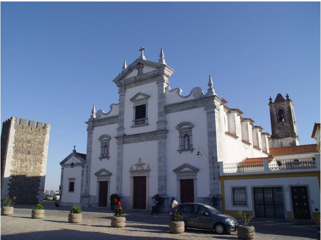
Figura 1. Alçado principal e sul da igreja, onde se destaca a torre sineira, antes das obras.
